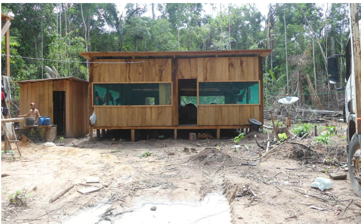
Figura 09 – Foto da Casa de Apoio ao PMFC na RESEX CAUTÁRIO
